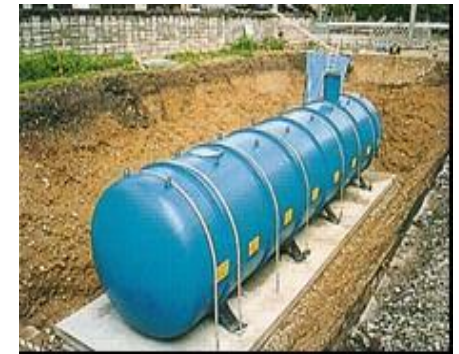
【耐震性貯水槽】
